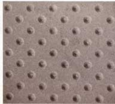
写真1 ノスキッド仕上げコンクリート表面
